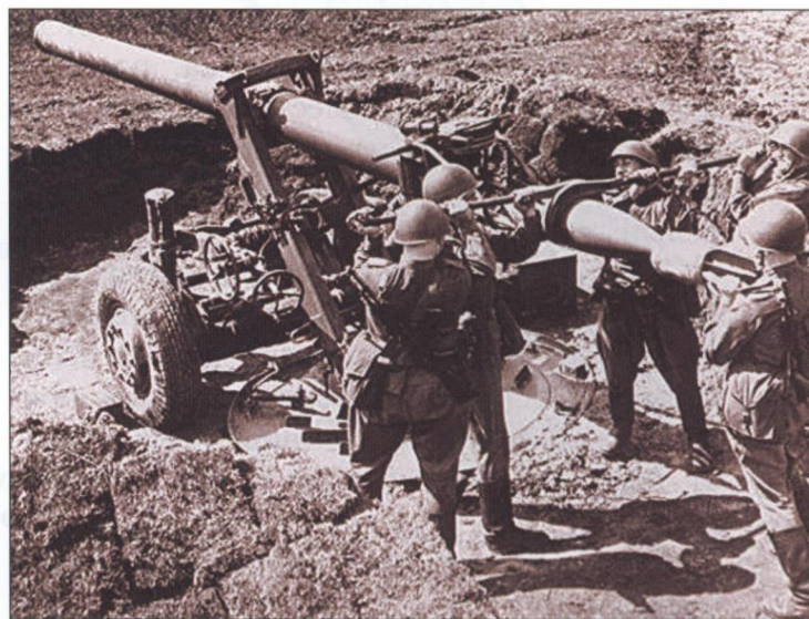
Заряжание миномета М-240 с казенной части
